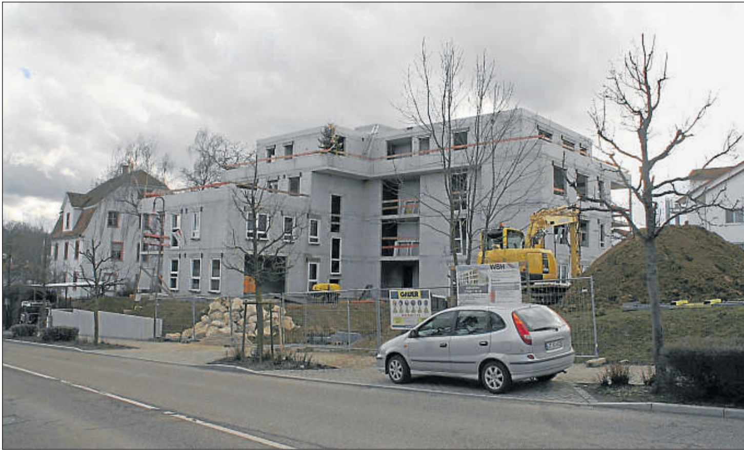
Gestern Nachmittag wurde Richtfest bei den seniorengerechten Wohnungen in Hochdorf gefeiert.
